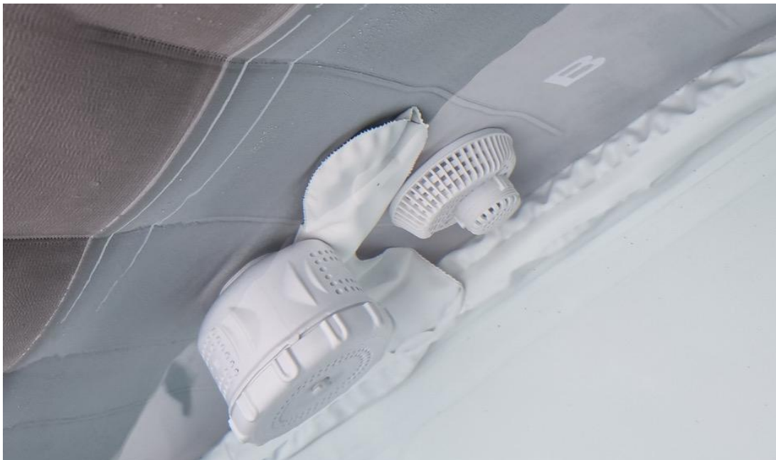
Filterkartuschenbehälter falsch montiert:
